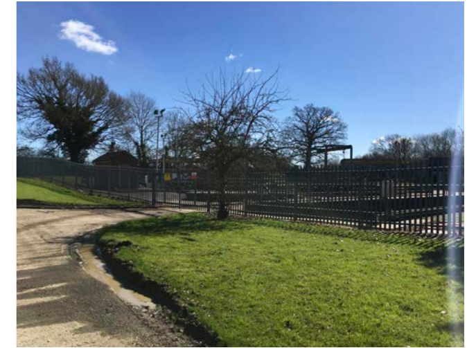
WWTW (odour zone)
